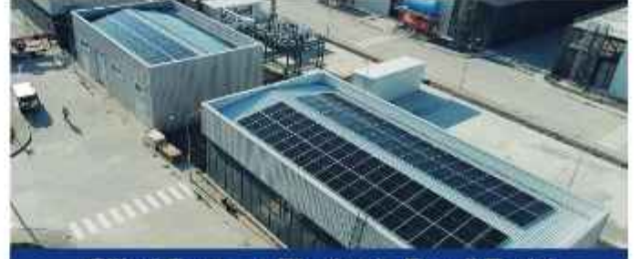
Silivri Seymen Biyokütle Enerji Tesisi
